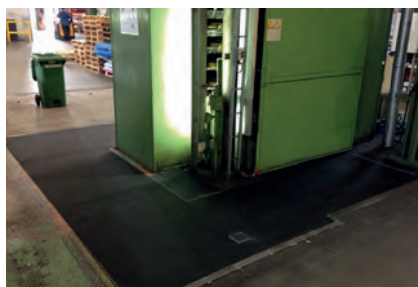
Montage op staal
