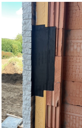
3. BUITENSPOUWBLAD + ISOLATIE + DEEL BINNENSPOUWBLAD
