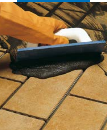
Voegen van een klinkervloer buiten met Keracolor GG aangemaakt met Fugolastic
