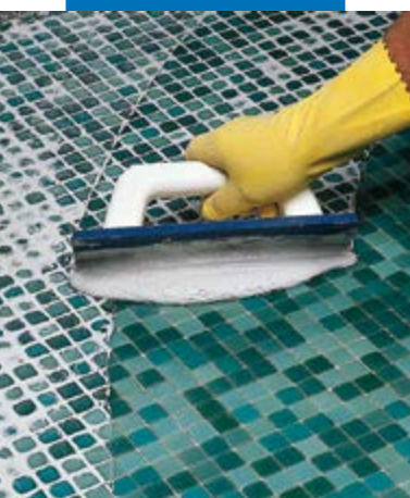
Voegen van glasmazaïek met Keracolor FF aangemaakt met Fugolastic
