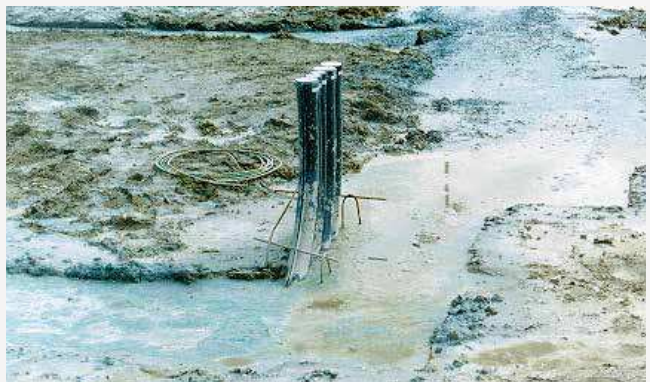
Aansluitbocht in fundering in volle grond
