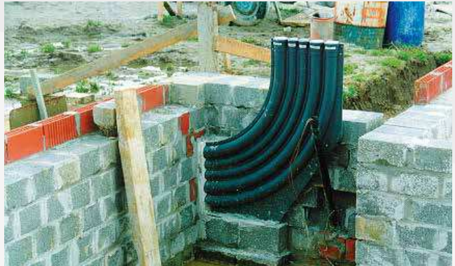
Aansluitbocht in fundering met kruipruimte
