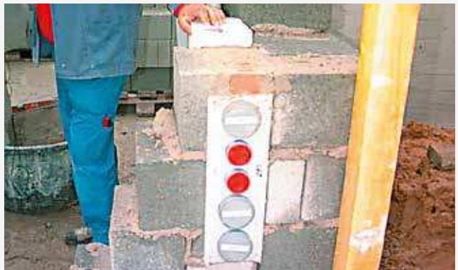
Toegangsopeningen van de aansluitbocht in funderingsmuur
