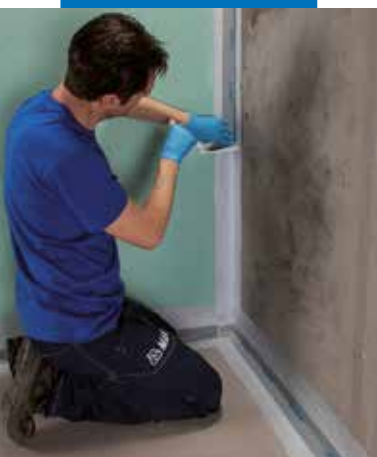
Aanbrengen van Mapeband PE 120 met Mapegum WPS
