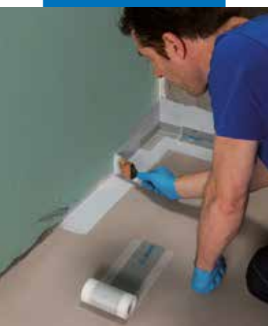
Aanbrengen van Mapeband PE 120 met Mapegum WPS
