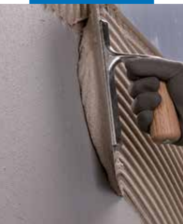
Aanbrengen van vloerbedekking met Ultramastic III
