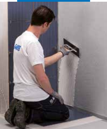
Aanbrengen van wandbekleding met Keraflex Maxi S1
