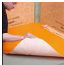
bij 8. Verlijm Schlüter®-DITRA-25 resp. DITRA-HEAT erop vast
