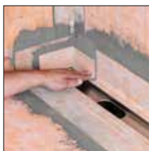
bij 3. Verlijm de KERDI-KERECK-binnenhoek
