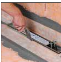
bij 3. Breng dunbedmortel aan / betegel het hele oppervlak
