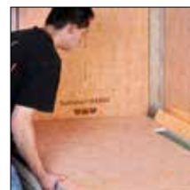
bij 3. Hellingplaat onder de rand van de goot schuiven
