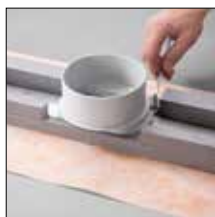
bij 3. Schroef de adapter weer vast.
