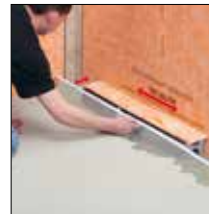
bij 4. Lijn de gootdrager uit
