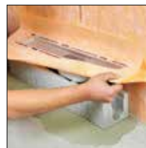
bij 2. Goot plaatsen
