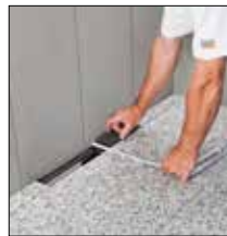
bij 4. Bepaal de afmetingen van de bekleding voor de tegeldrager ...
