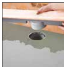
bij 4. Plaats de goot incl. gootdrager
