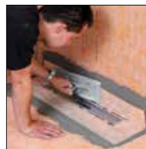
bij 4. KERDI-manchet met KERDI-COLL-L verlijmen
