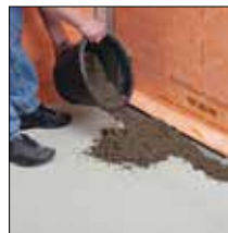
bij 3. Nivelleringslaag aanbrengen
