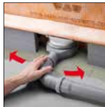
bij 5. Lijn het afvoerbuis uit
