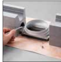
bij 2. Schroef de adapter weer vast.
