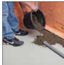
bij 6. Breng een dekvloer met afschot aan
