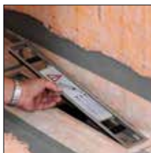
bij 1. Plaats het frame incl. de afstandsstrook
