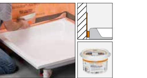
**5 a** Schlüter®-KERDI-TS an anschließenden Flächen mit Dichtkleber Schlüter®-KERDI-COLL-L unter Verwendung einer Zahnkelle (3 x 3 oder 4 x 4 mm) vollflächig einbetten. Sonderlösungen für Anschlussflächen siehe 5b.
