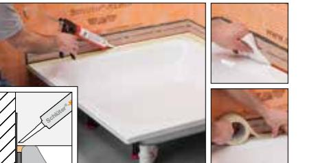
**6** Fugenbereich mit dem zweiten Reinigungstuch säubern und Randoberfläche des Einbauteils mit einem Malerband abdecken. Die Fuge mit Montagekleber Schlüter®-KERDI-FIX bis Oberkante Wannenrand verfüllen. Anschließend Malerband wieder entfernen. Frische KERDI-FIX Kleberreste können mit Sprühöl (z. B. WD-40) entfernt werden. Fläche anschließend gründlich entfetten.
