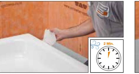
**1** Auflagefläche des Einbauteils gründlich mit beliebigem Reinigungstuch säubern und mind. 2 Minuten trocknen lassen.
