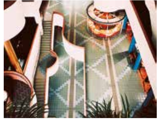
"Porcelain" plavuizen gelegd met Kerabond + Isolastic - Civic Center - North York Ontario (Canada)
