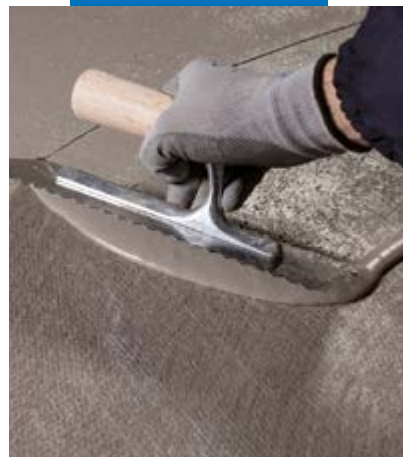
De tweede laag Mapelastic Turbo op de eerste met Mapetex Sel versterkte laag
