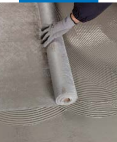
Plaatsen van Mapenet Sel op de nog natte eerste laag Mapelastic Turbo
