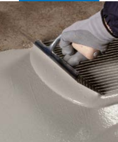
Aanbrengen van de eerste laag Mapelastic Turbo
