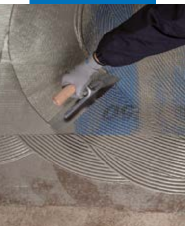
Plaatsen van Mapenet 150 op de nog natte eerste laag Mapelastic Turbo
