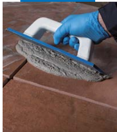
Afvoegen van tegels met Ultracolor Plus
