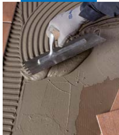
Verlijmen van tegels met Elastorapid
