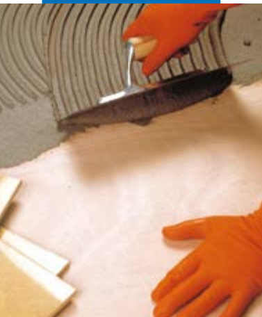
Met Elastorapid aanbrengen van gres porcellanato op multiplex hechthout
