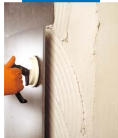
Het met Elastorapid plaatsen van groot formaat porselein tegels op een beton gevel
