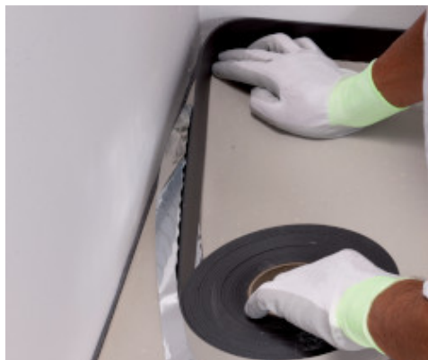
Breng de Mapesonic Strip-lijmtape rondom in de ruimte aan
