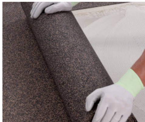
De banen van Mapesonic CR op de te isoleren ondergrond uitrollen
