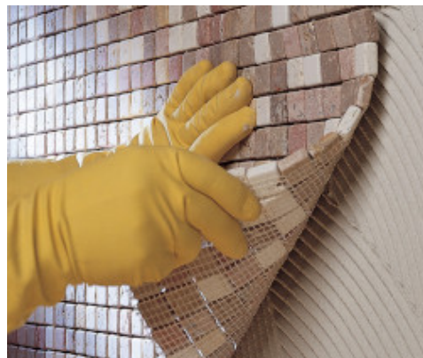
Verlijmen van 2x2 marmermozaïek op een wand
