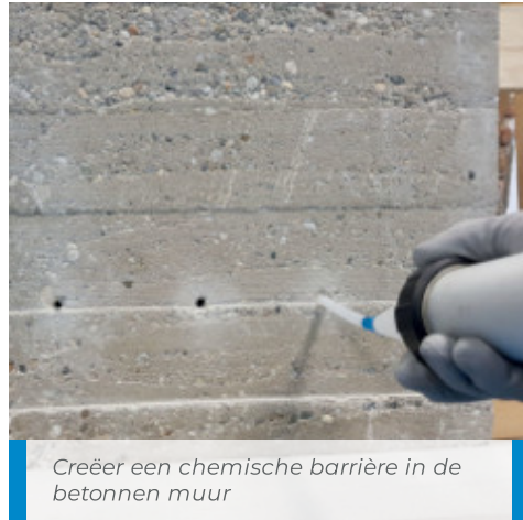
Steek de zachte worst in de kitpistool en snij vervolgens het uiteinde van de worst af aan de kant waar de ringmoer wordt vastgeschroefd
