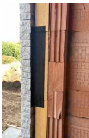
2. MUR CAVITÉ EXTÉRIEURE + ISOLATION
