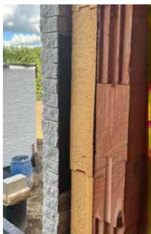
1. MUR CAVITÉ EXTÉRIEURE
