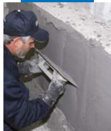
Aanbrengen van Nivoplan met een strijkbord
