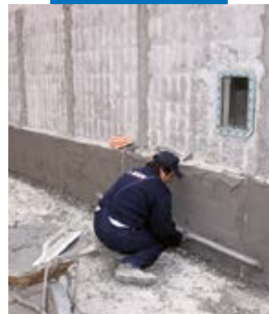
Uitvlakken van Nivoplan met een reilat
