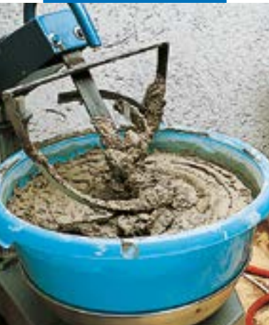
Mengen met een kleine betonmolen
