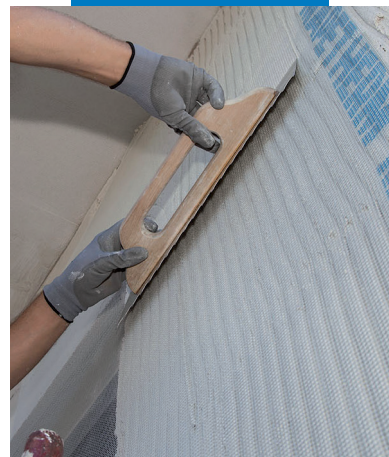
Inbedden van het Mapetherm Net-wapeningsnet
