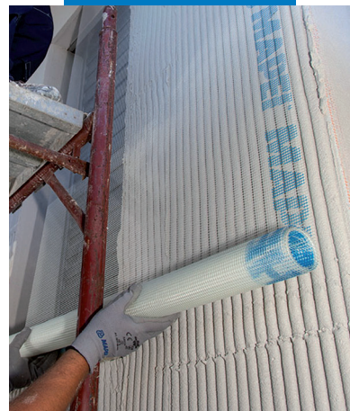
Aanbrengen van Mapetherm Net in de eerste egaliseerlaag
