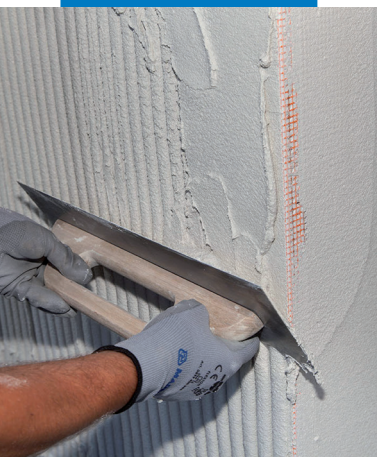
Aanbrengen van de eerste egaliseerlaag van Mapetherm AR1 Light
