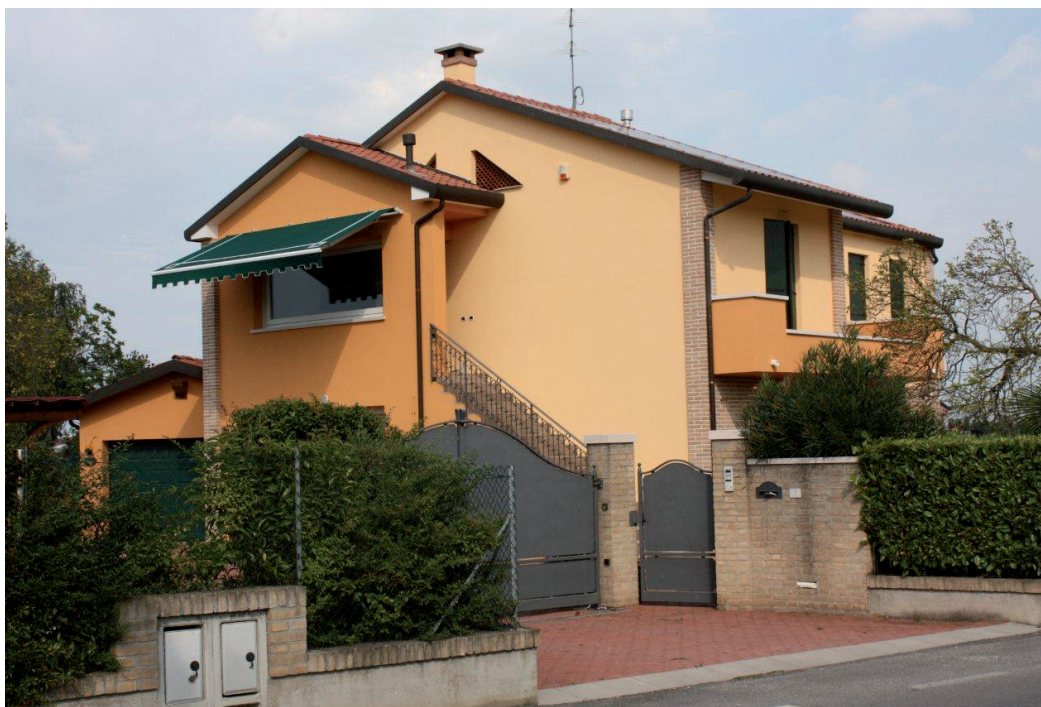
Aanbrengen van Mapetherm AR1 Light als een lijm en egaliseermiddel - Privéwoning - Noale (Venetië), Italië
