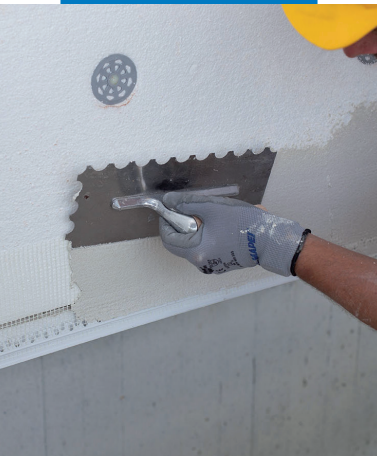
Aanbrengen van de Mapetherm Driprose Bead met Mapetherm AR1 Light
