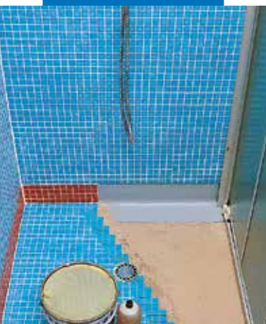
Waterdicht maken en leggen van tegels in een geprefabriceerde douchecabine
