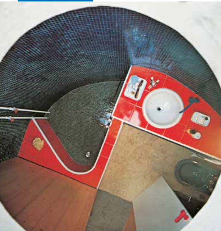
Waterdichte installatie van een bad en douche
