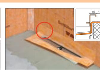
**4** Position der Linienentwässerung festlegen und Kernlochbohrung / Deckendurchbruch für Rohr DN 50 bzw. Ablaufgehäuse erstellen. Bei Brandschutzanforderung ist die Bohrung entsprechend der gewählten Brandschutzmanschette (bauseits) größer zu erstellen.
