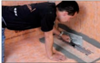
**11** KERDI Manschette mit KERDI-COLL-L. verkleben. Wand- und Bodenanschlüsse sind mit KERDI-KEBA ebenfalls mit KERDI-COLL-L. dicht zu verkleben.
