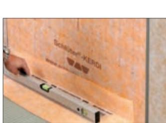
**8** Rinnenkörper mit Wasserwaage ausrichten.
