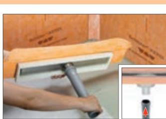
**5** Mitgeliefertes Ablaufrohr bedarfsgerecht kürzen und aufstecken (kleines Bild: Rohrmontage an Schlüter-KERDI-LINE-V 50 GE, mit Geruchsverschluss).
